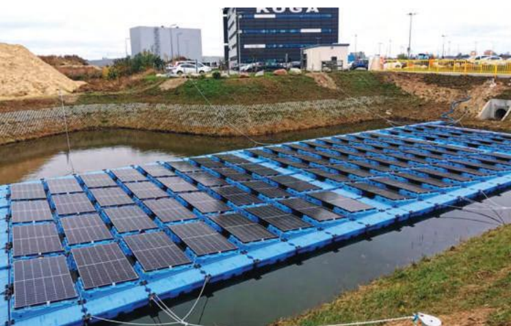
Pierwsza w Polsce fotowoltaika na zbiorniku wodnym na terenie Pomorskiego Centrum Inwestycyjnego.
